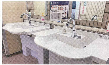
【トイレ洗面台改修】
